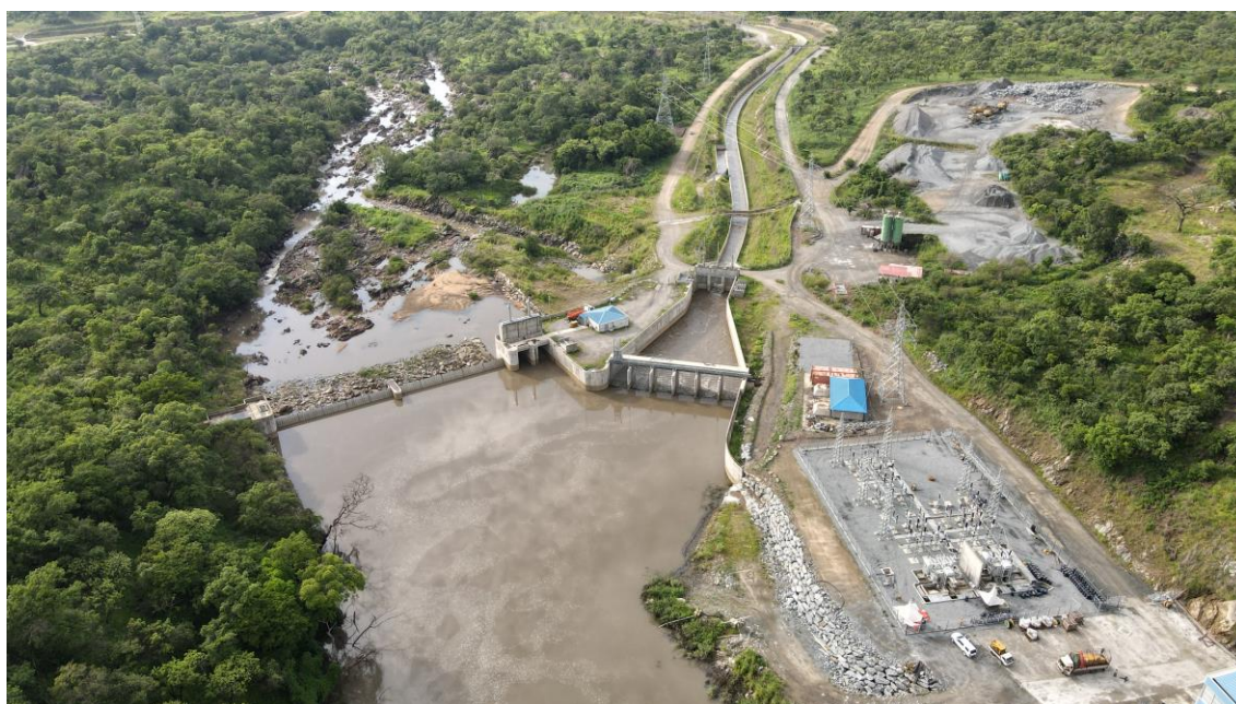
Traversa e opera di derivazione Impianto idroelettrico HPP2 in Uganda
