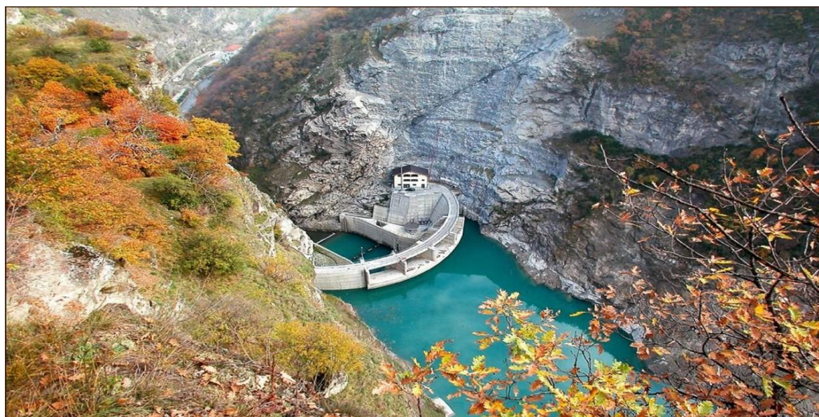
Diga di Susa
