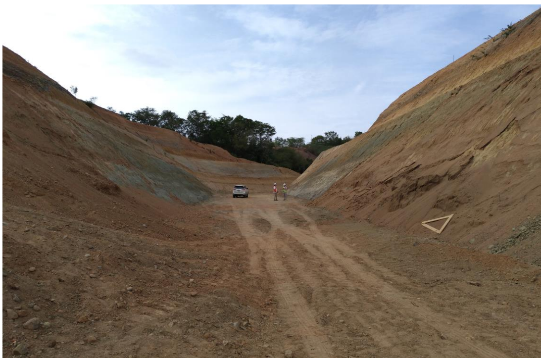
Diga di Guayubin nella Repubblica Dominicana-Scavo Canale di deviazione provvisoria
