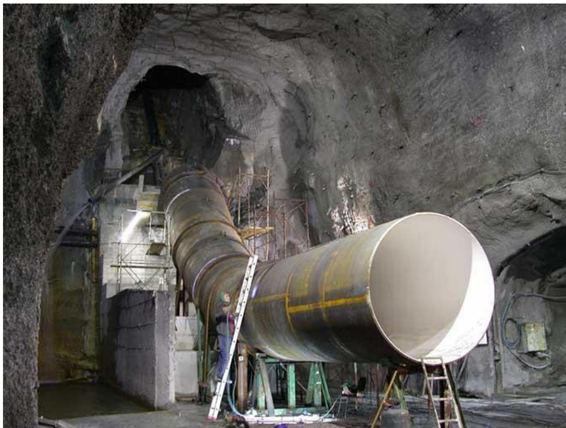
Realizzazione condotta forzata Impianto Premadio II
