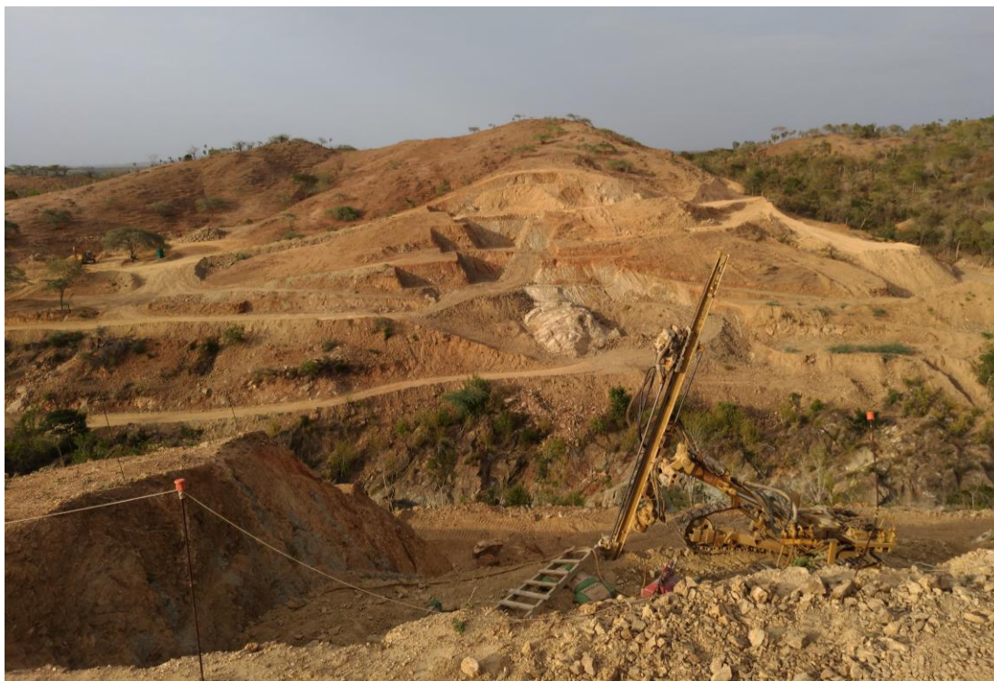
Scavi sezione di imposta Diga di Guayubin nella Repubblica Dominicana
