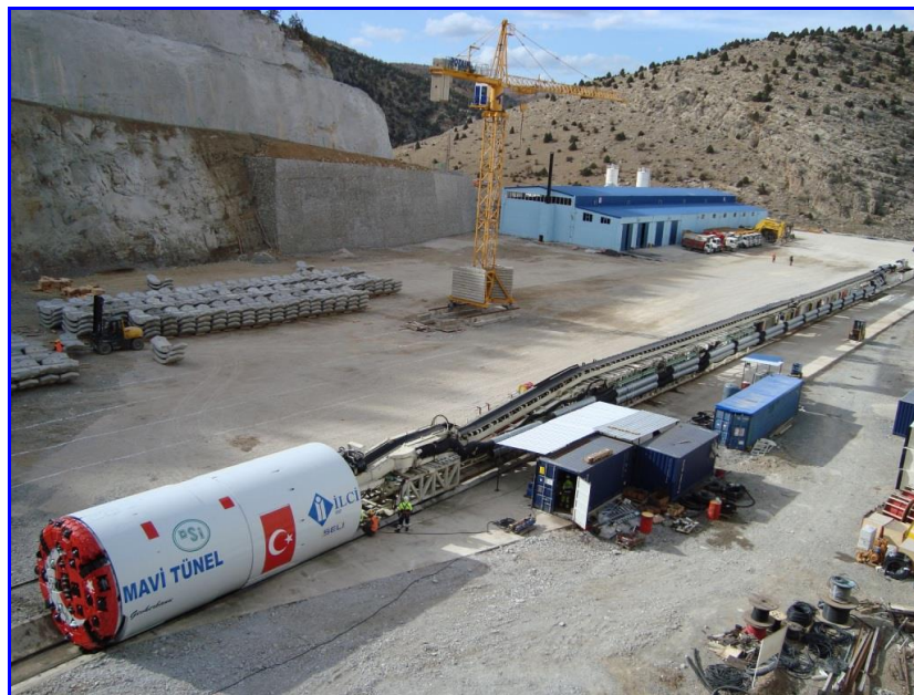
Cantiere Mavi Tunnel (Turchia)
