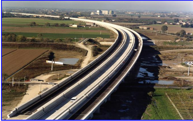
Linea Ferroviaria Alta Capacità Milano-Bologna
