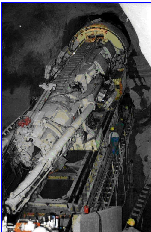
TBM per scavo condotta forzata
