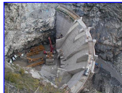
Diga Gorge di Susa (Alpi)
