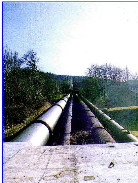
Particolare della nuova condotta forzata
