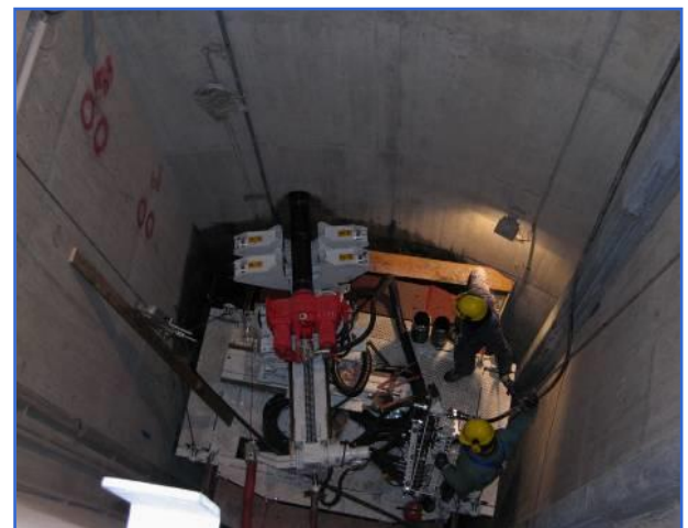
Piattaforma mobile per perforazione ed esecuzione tiranti nel vano parafodie Rinforzo
