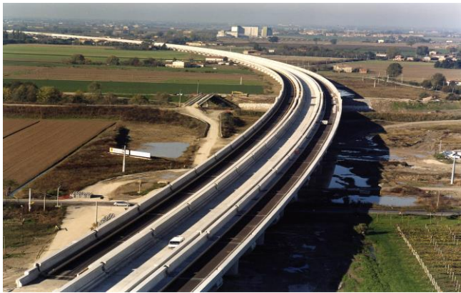
Linea Ferroviaria Alta Capacità Milano-Bologna
