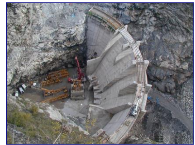
Diga Gorge di Susa (Alpi)
