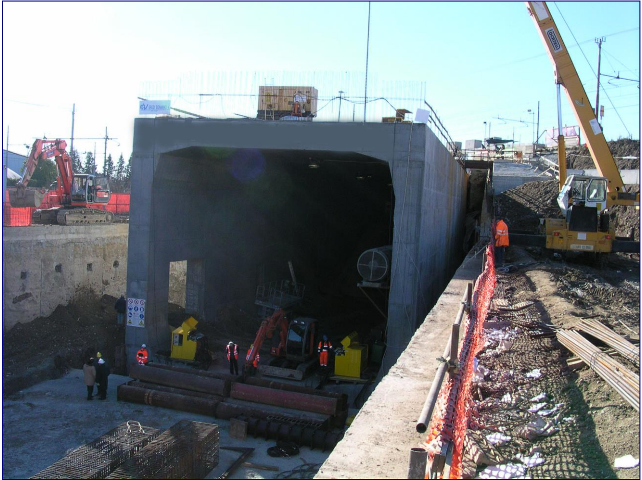
“Passante di Milano” – Monolite a spinta (martinetti idraulici 10000 t)
