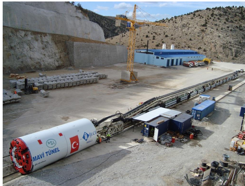
Cantiere Mavi Tunnel (Turchia)
